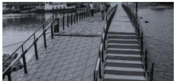
б) Полимерный понтонный мост с пешеходной и проезжей частью
