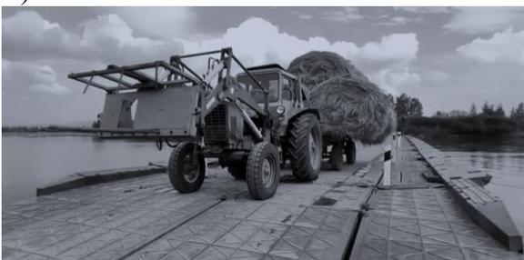
а) полимерный понтонный мост с металлизированным покрытием
